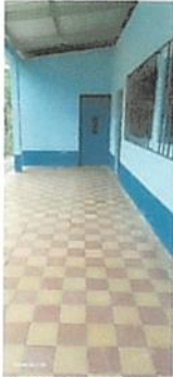
Foto 3: SE CAMBIO PUERTA METÁLICA EN BODEGA
