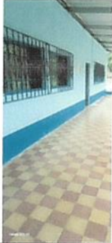
Foto 1: SUSTITUCION DE VENTANAS DE METAL POR VENTANAS CORREDIZAS EN AULAS
